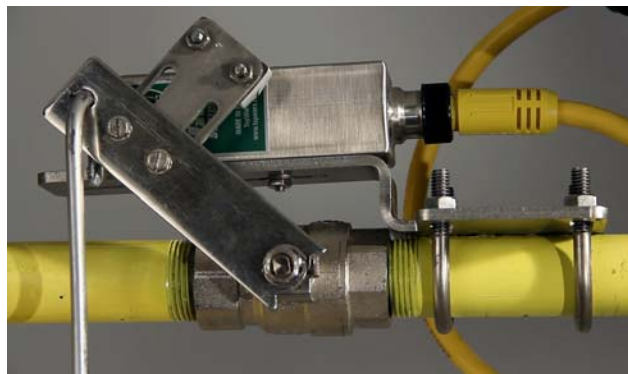
Рисунок 18. Клапан аварийного душа, приведенный в действие.
