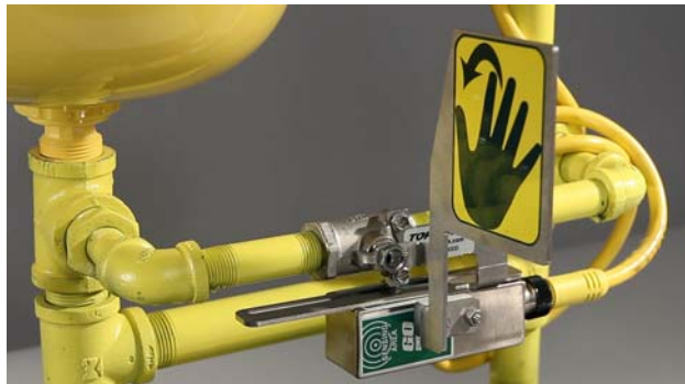
Рисунок 20. Установка для промывки глаз приведена в действие.
