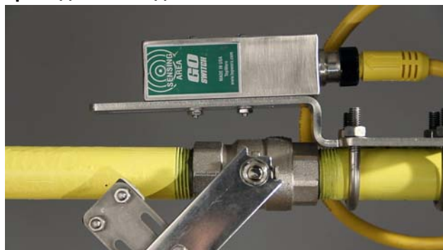
Рисунок 18. Клапан аварийного душа, приведенный в действие.
